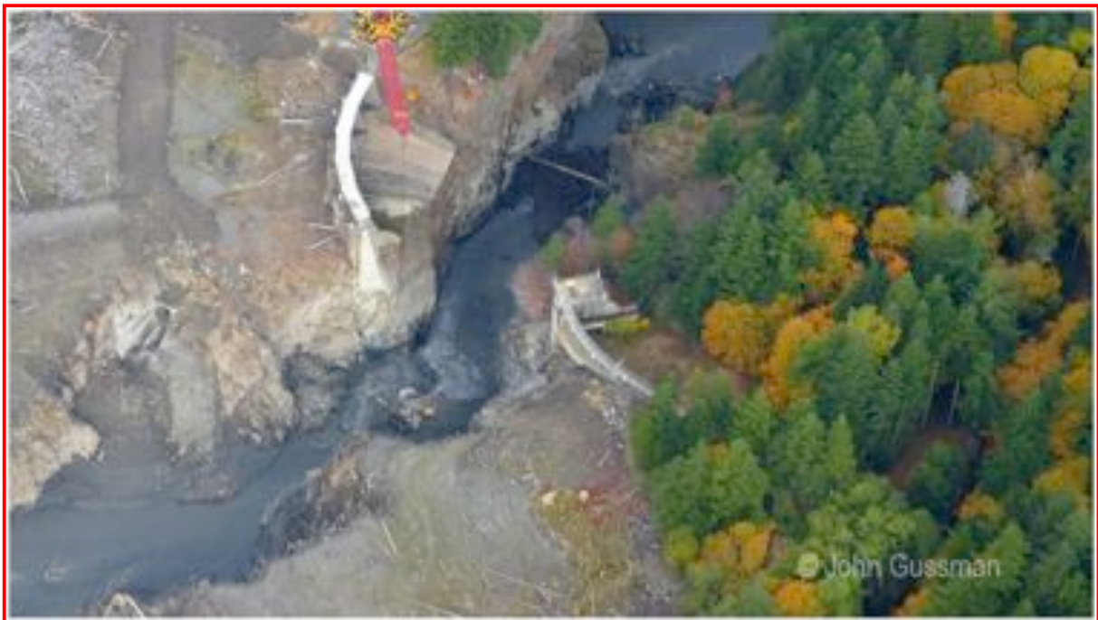
Déconstruction du barrage de Glines Canyon – 64 mètres de hauteur
