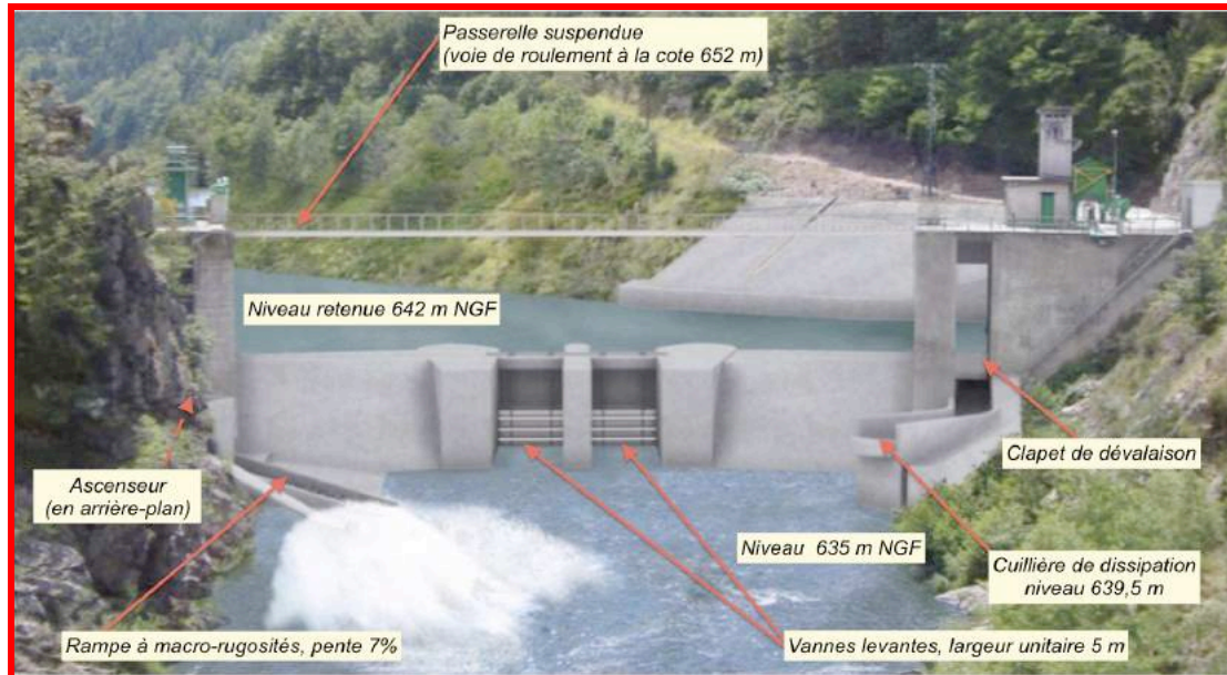
PHOTO VIRTUELLE DU POUTÈS OPTIMISÉ (d'après document EDF), les indications ont été ajoutées (flèches et textes).
