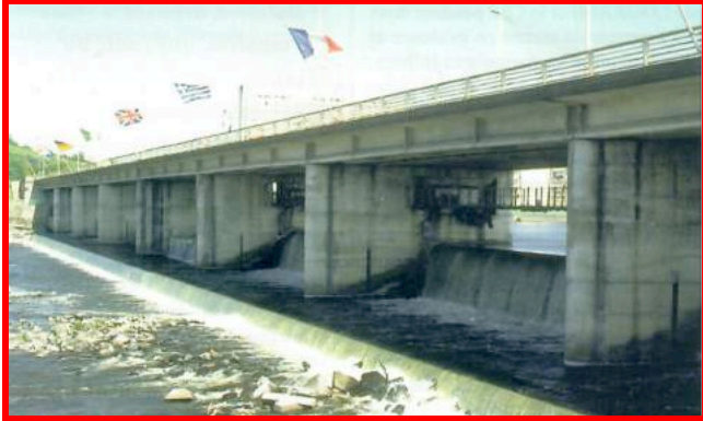
Le barrage de Vichy (photo CSP)
