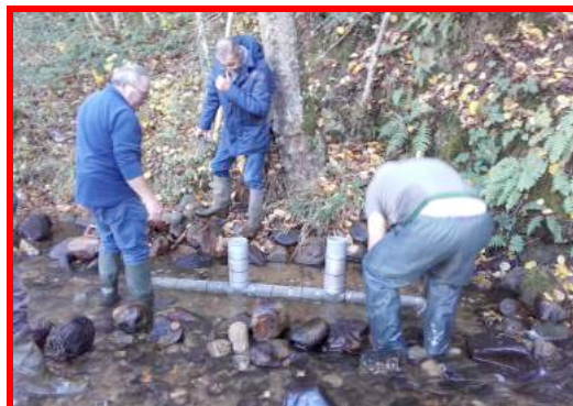
Incubateurs : travaux de réfection des prises d'eau (novembre)
