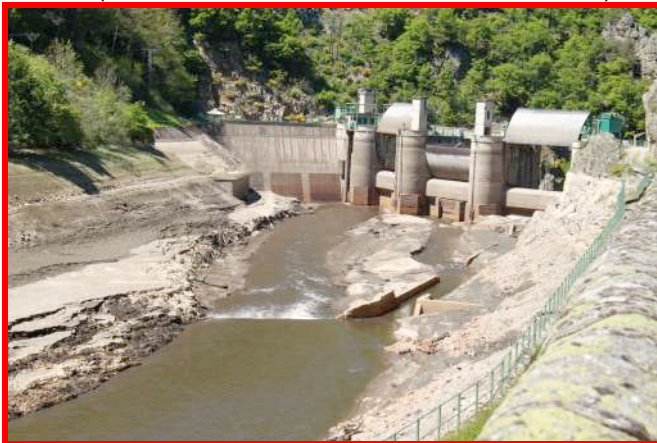
Photo N°2 du 31 mai 2019 (APS) En amont : l'ouvrage de dérivation provisoire
