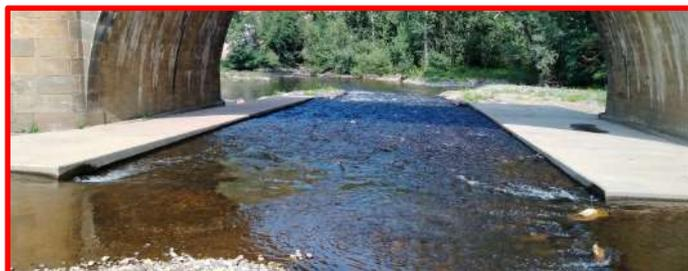
**N°6** Amont du dispositif central de montaison après les travaux (réalisation en 2022)
