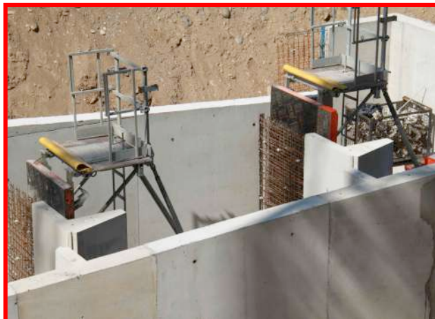
Détail d'un bassin (construction en cours)
