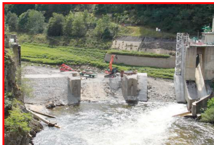
Aval du barrage
