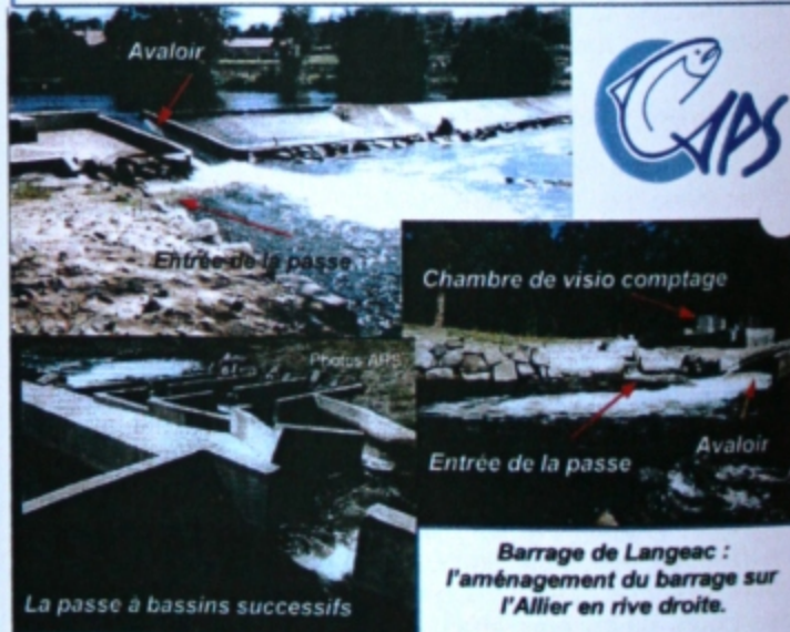
Photo de gauche : Rive gauche de l'Allier la sortie de la passe et la chambre de visualisation. Photo de droite : la nouvelle passe à paliers successifs
