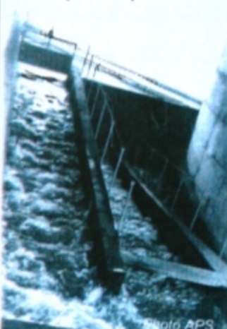
Photo APS Première échelle construite en rive droite
