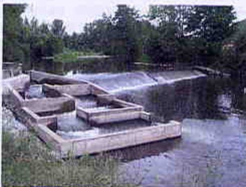
Barrage de l'Alagnon à l'aval de Massiac (14 Août 2008)
