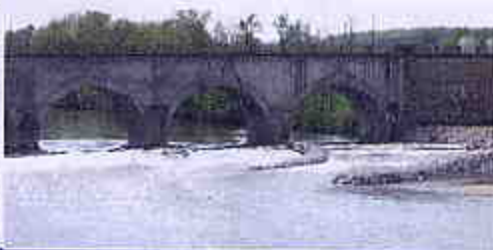
Aménagement réalisé au Pont du Guétin (2 Mai 2008)
