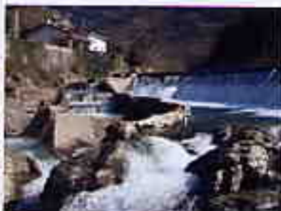
Barrage et échelle sur le rio SELLA
