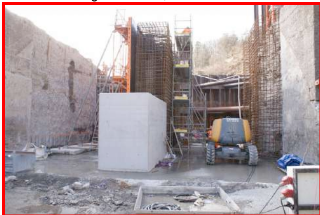
7 - La partie basse du plot central des vannes, le 19/02/2021
