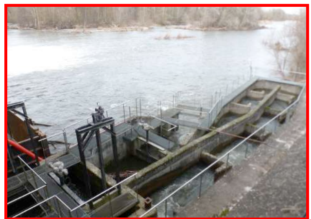
Le pied de la passe à poissons le 16 février (Débit à Saint-Yorre 167,5 m 3 /s)
