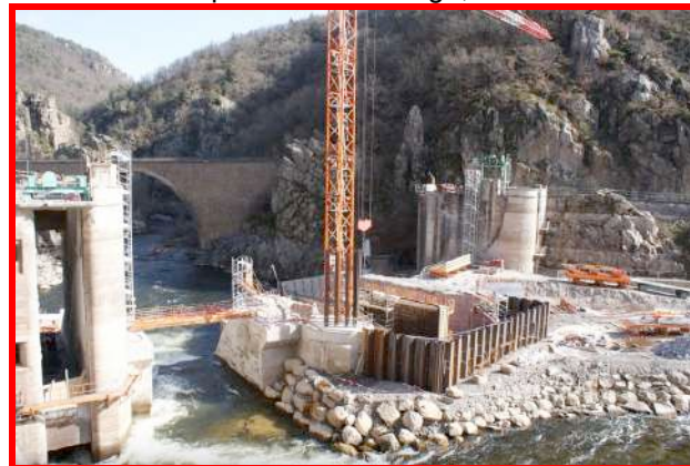
8 - Vue générale du chantier, le 19/02/2021
