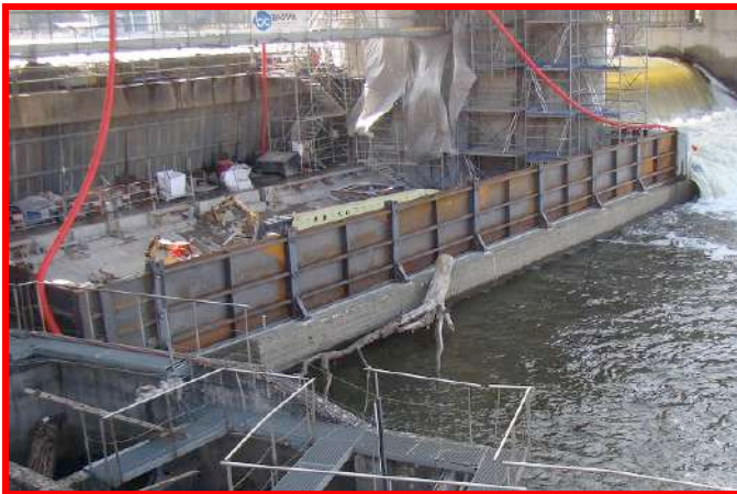
Le chantier au 21 février 2021
