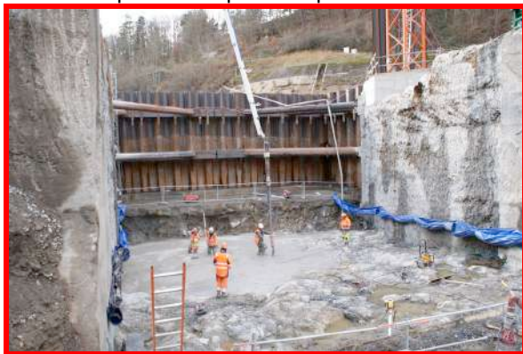
5 - Coulage du béton, le 23/12/2020
