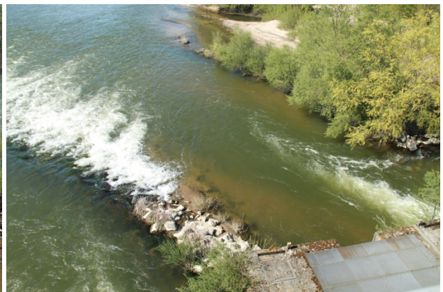
La rampe rustique près de la rive gauche et l'entrée de la passe à poissons , le guidage des poissons vers l'entrée de la passe est soigné. Photos APS du 10 avril 2025 (débit 215 m 3 /s à Gien).
