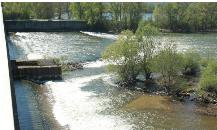
La rampe rustique près de la rive gauche et l'entrée de la passe à poissons , le guidage des poissons vers l'entrée de la passe est soigné. Photos APS du 10 avril 2025 (débit 215 m 3 /s à Gien).
