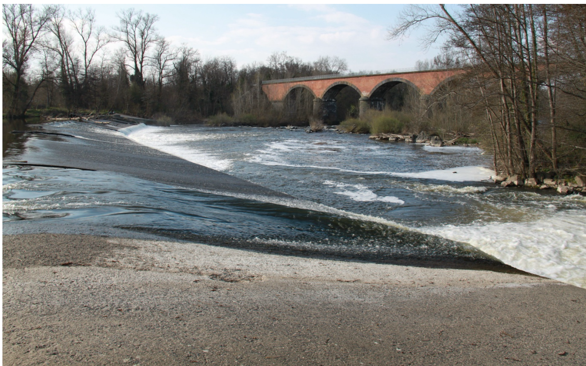
Le Barrage de La Bageasse : hauteur de chute 3 mètres, crête de longueur 160 mètres, en briques rouges le viaduc SNCF.
