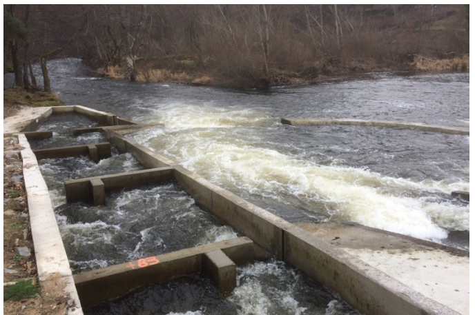
Vues sur les bassins de la passe à poissons
