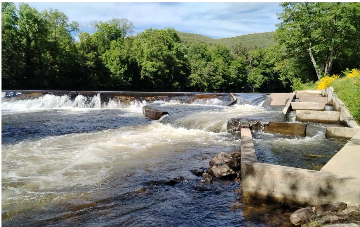
Le dispositif de montaison et la glissière à canoës (le 18 mai 2025). Débit 25 m 3 /s à Vieille Brioude
