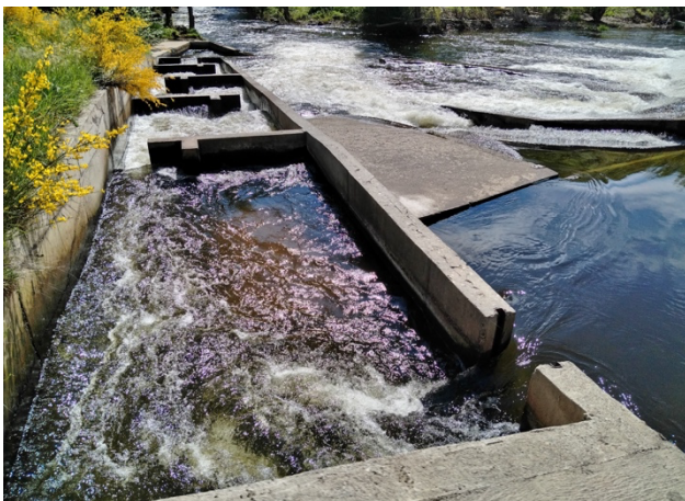
Vues sur les bassins de la passe à poissons
