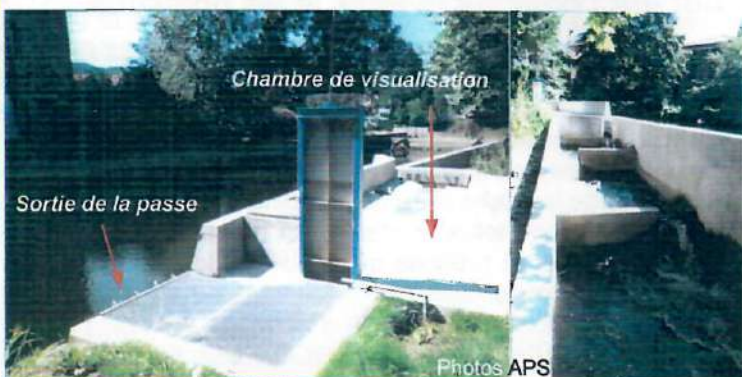
Photo de gauche : Rive gauche de l'Allier la sortie de la passe et la chambre de visualisation. Photo de droite : la nouvelle passe à paliers successifs
