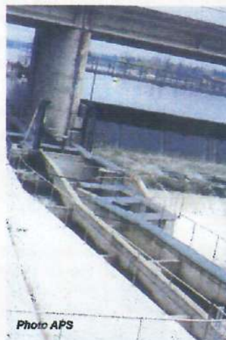
Pont Barrage de Vichy :
