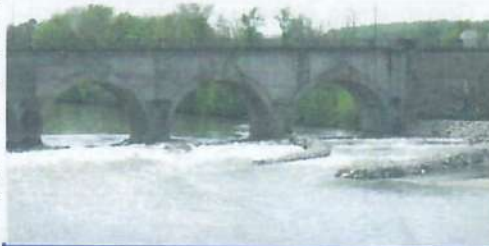
Aménagement réalisé au Pont du Guétin (2 Mai 2008)
