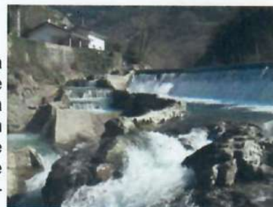
Barrage et échelle sur le rio SELLA
