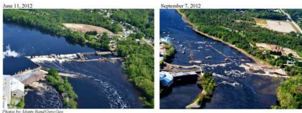
Le barrage de Great Works avant (Juin 2012) et après sa démolition (Septembre 2012)
