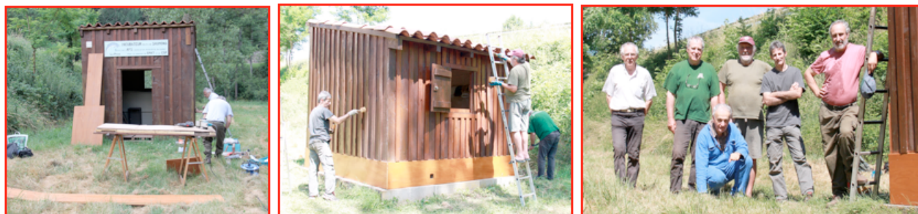
Quelques phases des travaux et les membres de l'APS qui ont pris part
