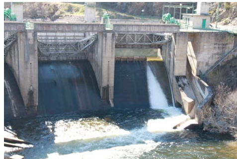
Poutès la rampe de dévalaison (en mars 2017), barrage à la cote 644m
