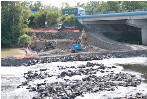
Travaux au seuil de l'A89 (28 juillet 2017)
