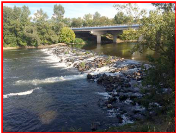
Le seuil en 2015 avec un débit de l'Allier de 15 m 3 /s
