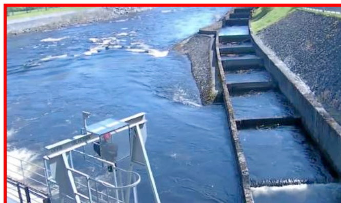
Vue de la partie inférieure de la passe à poissons (photo internet)
