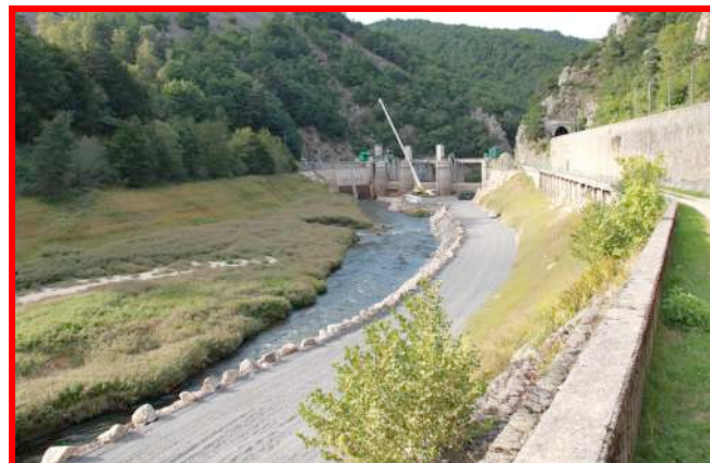
La piste d'accès à la plateforme de travail (le 5 septembre)
