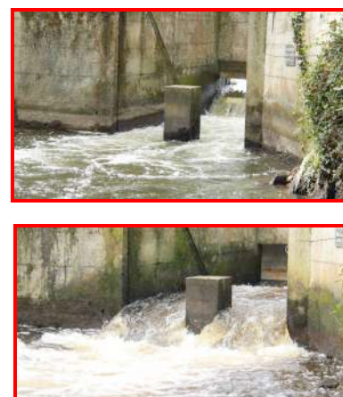
La Bageasse : avant et après intervention APS (Entrée du bassin amont)
