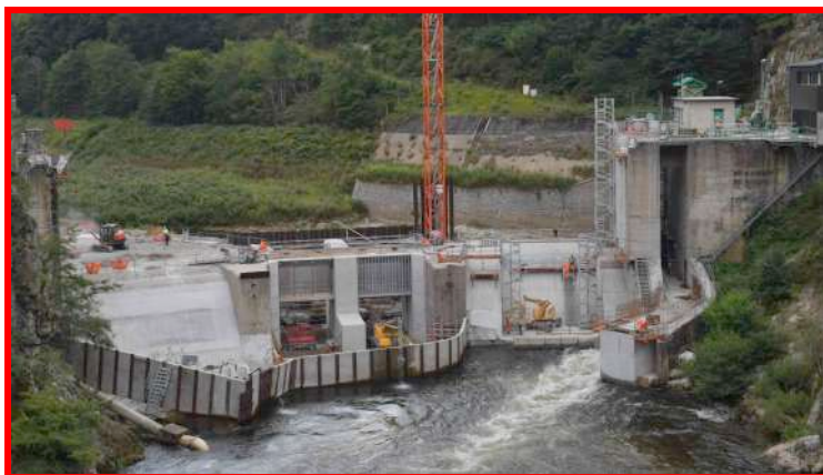
Travaux de Poutès au 22 août 2021
