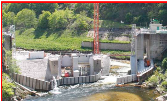
Travaux de Poutès au 26 mai 2021
