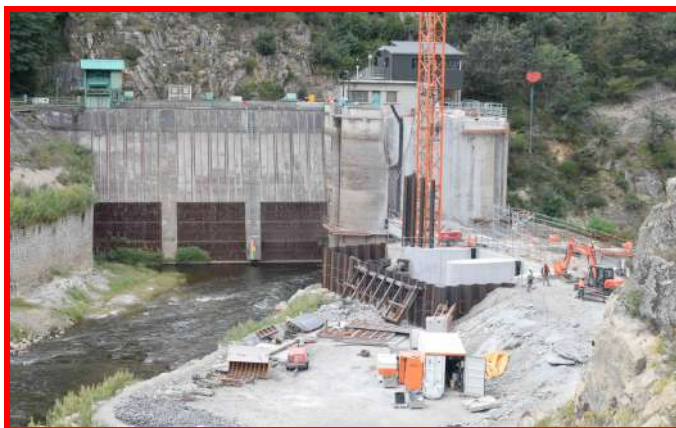
Amont du barrage au 22 août 2021
