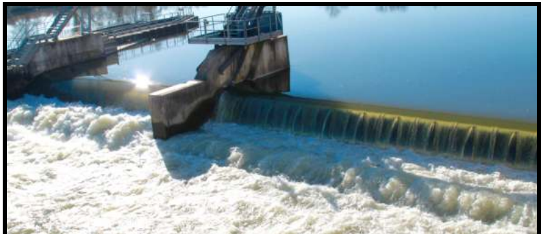
Photo N°2 : Le positionnement des clapets
