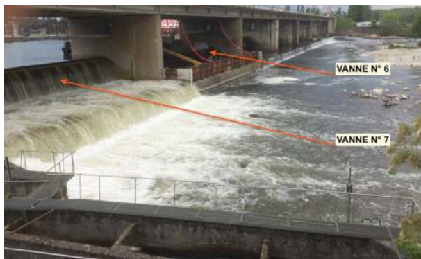
Photo N° 9 : Vichy, le 4 mai 2022 notez le transfert de débit
