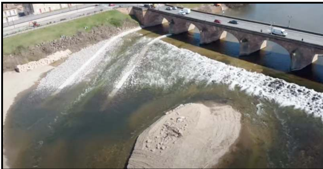
Photo N°4 - La nouvelle passe à poissons de Moulins en rive droite du pont Régemortes (source : Moulins TV)
