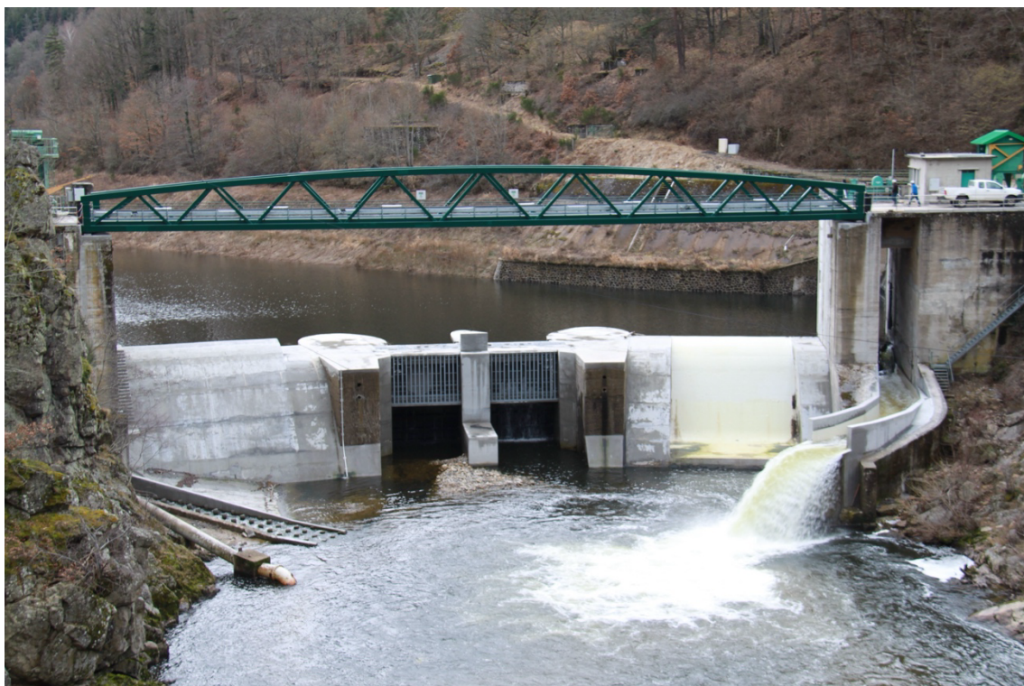
Le Barrage de Poutès, à droite la goulotte de dévalaison des smolts (Photo A.P.S.)
