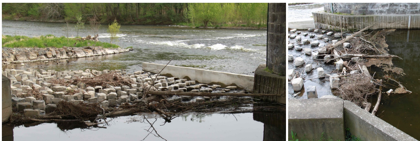
Pont du Château : arrêt des embâcles en amont de la passe à poissons située rive gauche.
