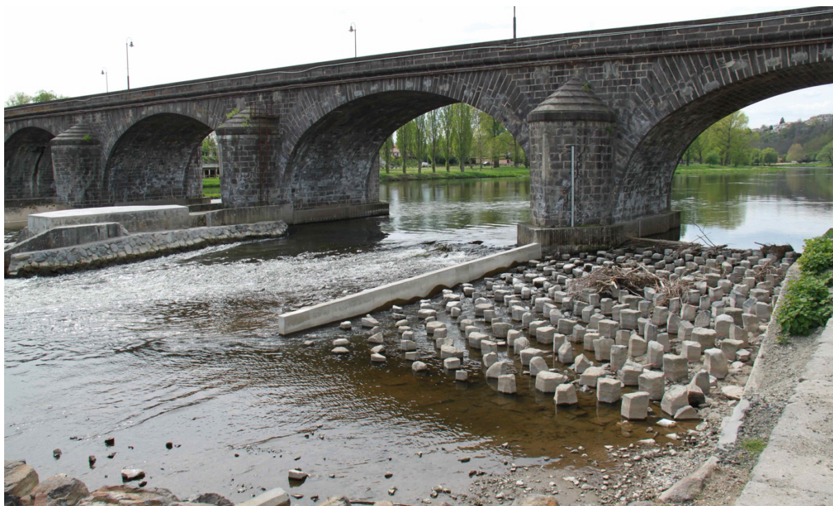
Pont du Château : passe à canoës et passe à poissons à rampe "dite naturelle"
