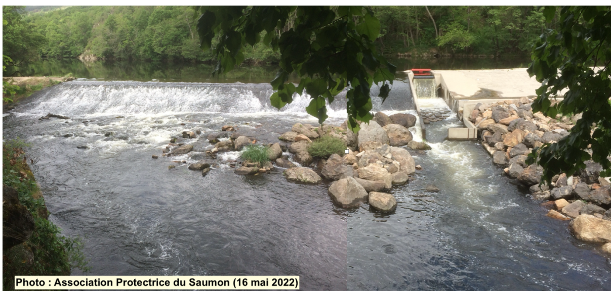
Le Barrage de Vieille-Brioude (le 16 mai 2022) : hauteur de chute 2 à 2,8 mètres, crête de longueur environ 120 mètres hors tout, déversement sur 40 mètres.
